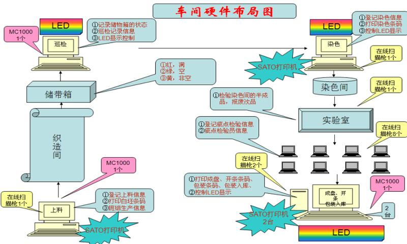
在采用生产线条码技术后, 首先将订单号、零件种类、产品数量编号形成条码, 在产品零件和装配的生产线上打印并粘贴条码。这样就可以很方便的获取产品订单在某条生产线上的生产工艺及所需的物料和零件。
